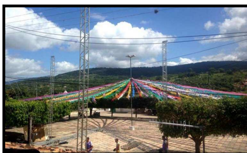
Figura 56. Montagem da estrutura para o Arraiá Pindura Saia/Cachoeira Grande
