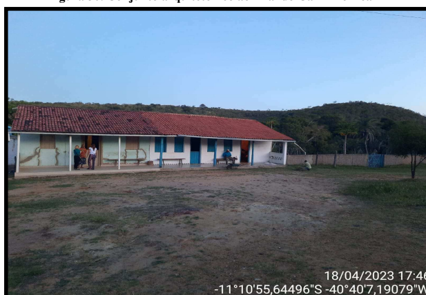
Figura 30. Conjunto arquitetônico ao final do Caminho Real
